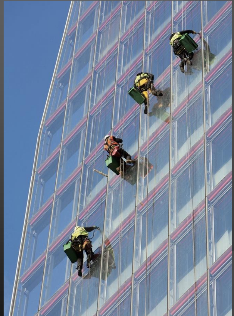
Lavoratori su funi allo Shard London Bridge Tower
